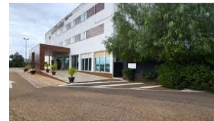
Hotel las Bóvedas
